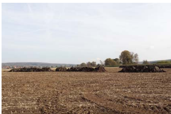
11.000 m 3 Boden wurden über 10 km transportiert, auf landwirtschaftliche Flächen gebracht und eingearbeitet.
