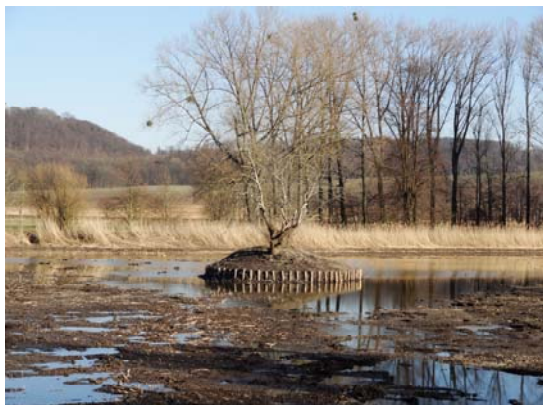
Die Insel und das Westufer wurden mit Faschinenwänden gesichert.
