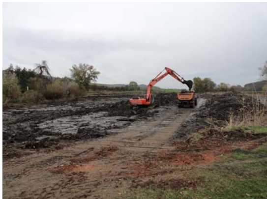
Die Entschlammung erfolgte bei abgelassenem Teich über eine provisorische Baustraße aus Baggermatratzen.
